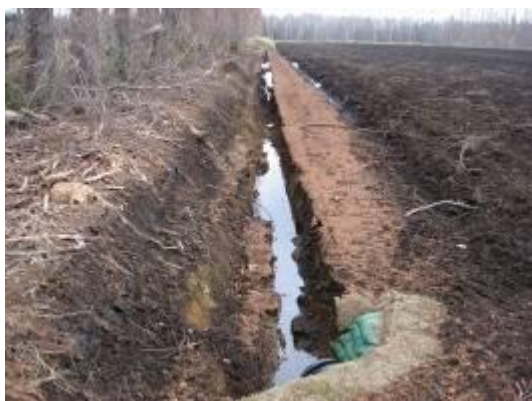
写真2 ほ場周縁に設置した簡易排水
