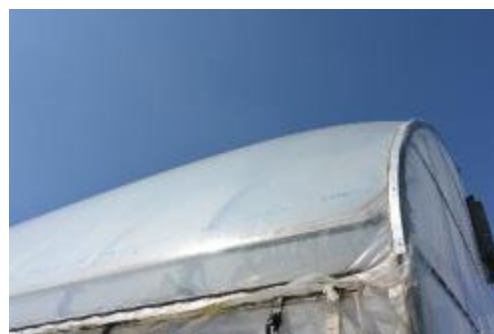
写真17 空気膜二重構造ハウス 膨らんだ天井ビニール
